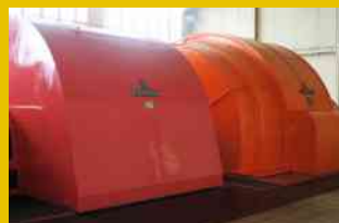
Convertisseur de fréquence à Karlsruhe: à gauche se trouve le moteur (rouge), à droite le générateur (orange). (Photo: M. Westenthanner, Wikipédia allemand)
